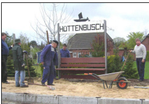
Mitglieder des Ortsrates und der „Rüstigen Rentner“ arbeiten am neuen Bahnsteig
