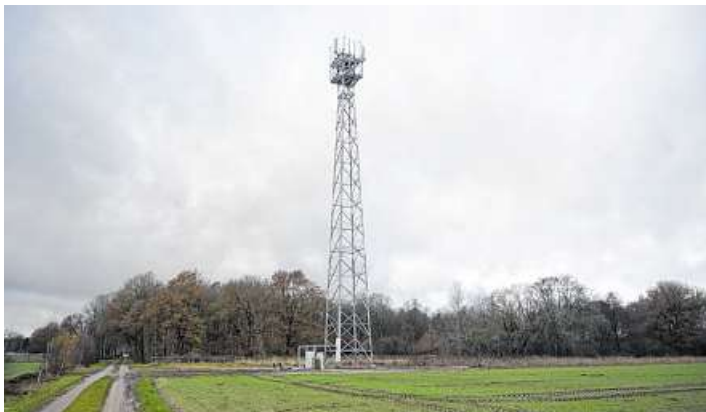
Etwas außerhalb am Schießstand befindet sich der Hüttenbuscher Funkturm.
