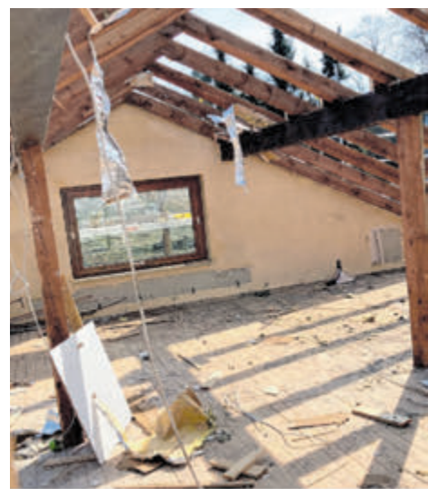
Das Haus von Lea und Tobias Wülpern in der Umbauphase. Das Satteldach wurde abgerissen. FOTO: LEA WÜLPERN
